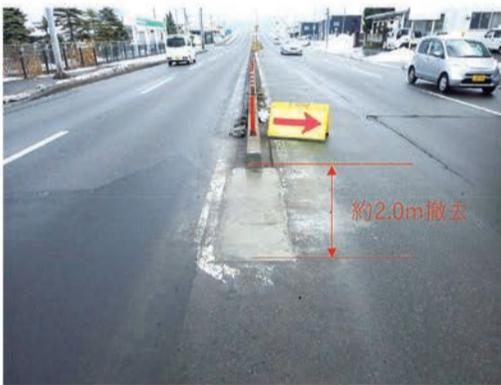
青森臨港道路 1 号線の青森市新田地内の中央分離帯を約 2 メートル撤去し、住宅地への車両の進入を容易にする一部改良工事が終了しました。
