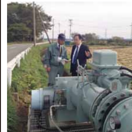
小水力発電施設を現地調査(七戸町)
